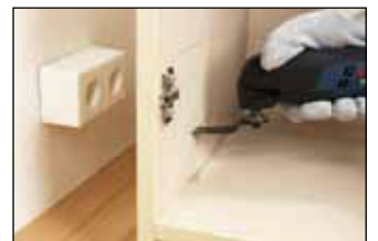
가구 절단 예) 콘센트 연결 작업
