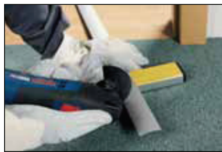
몰딩 절단 예) 알루미늄 바닥 커버 절단
